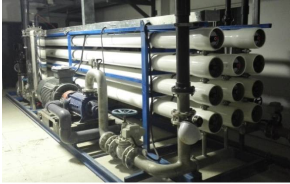
RO 反渗透设备
